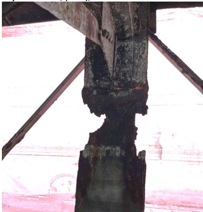
Figura N° 18. Pilote en muy mal estado, (A-15), en el área de maniobra de la operación.
