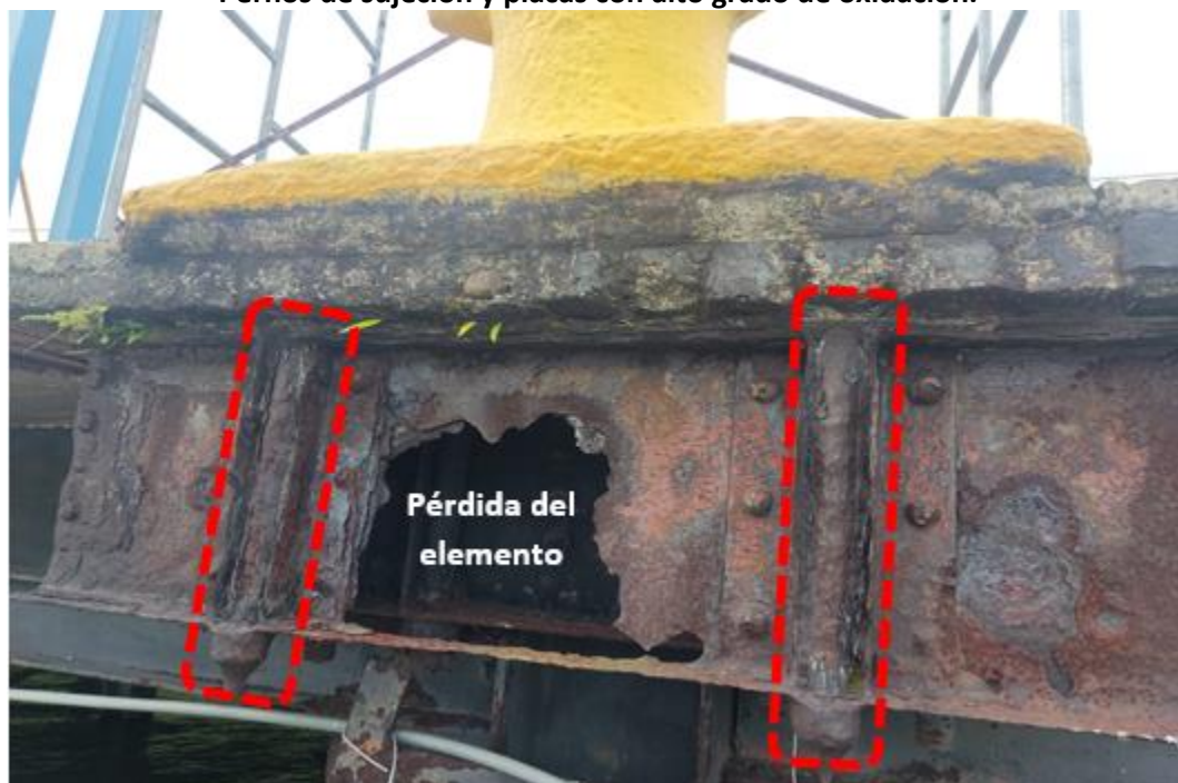
Figura N° 20. Pernos de sujeción y placas con alto grado de oxidación.
