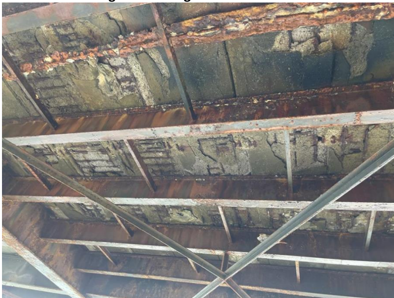
Figura N°10. Losas en muy mal estado, con desprendimiento de concreto, exposición del acero de refuerzo, vigas con alto grado de corrosión.
