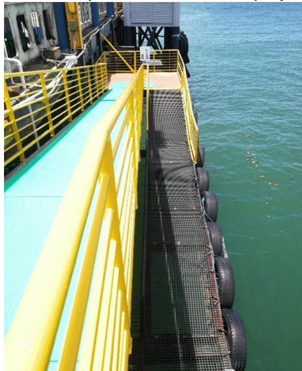
Figura N° 8 Pintura de barandas y mantenimiento de la rampa fija, Quepos.
