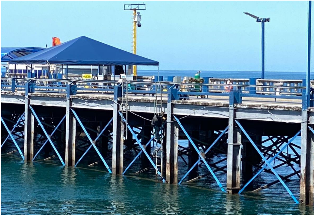
Figura N° 9 Reemplazo de tensoras o angulares, Muelle Quepos.
