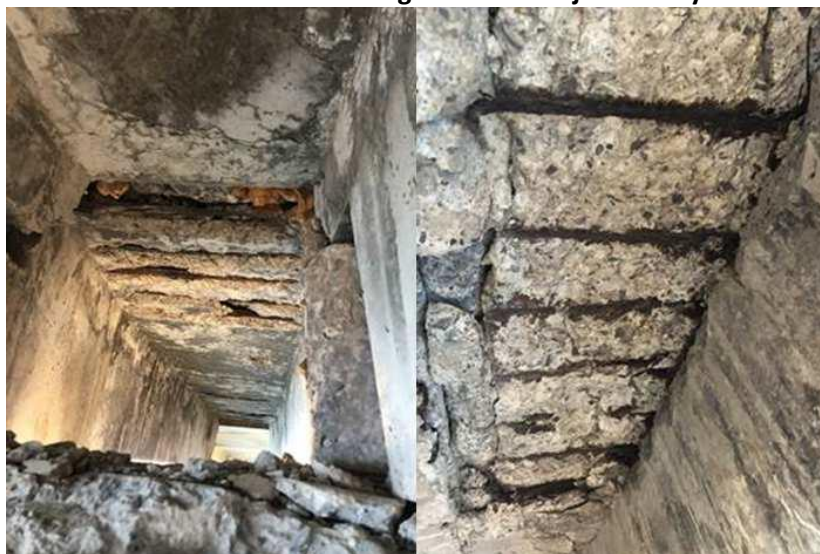
Figuras N° 14 Deterioro avanzado en las vigas entre los ejes 21-24 y 36-38.
