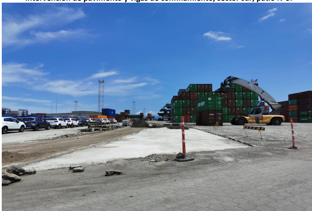
Figura N°3 Intervención de pavimento y vigas de confinamiento, sector sur, patio N°3.
