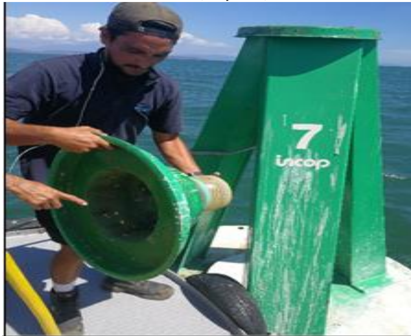
Figura N° 17 Cambio de luminaria, boya N°7, Puntarenas.
