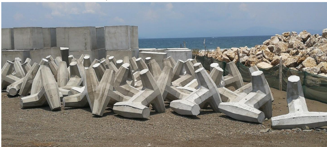
Imagen N°10 Dolos y cubos de concreto, fabricados en sitio.
