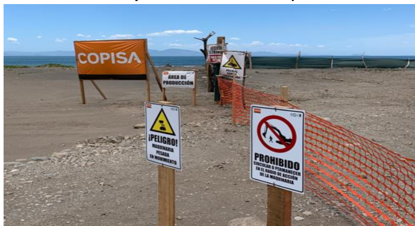
Figura N°11 Área de trabajo debidamente señalizada y demarcada.
