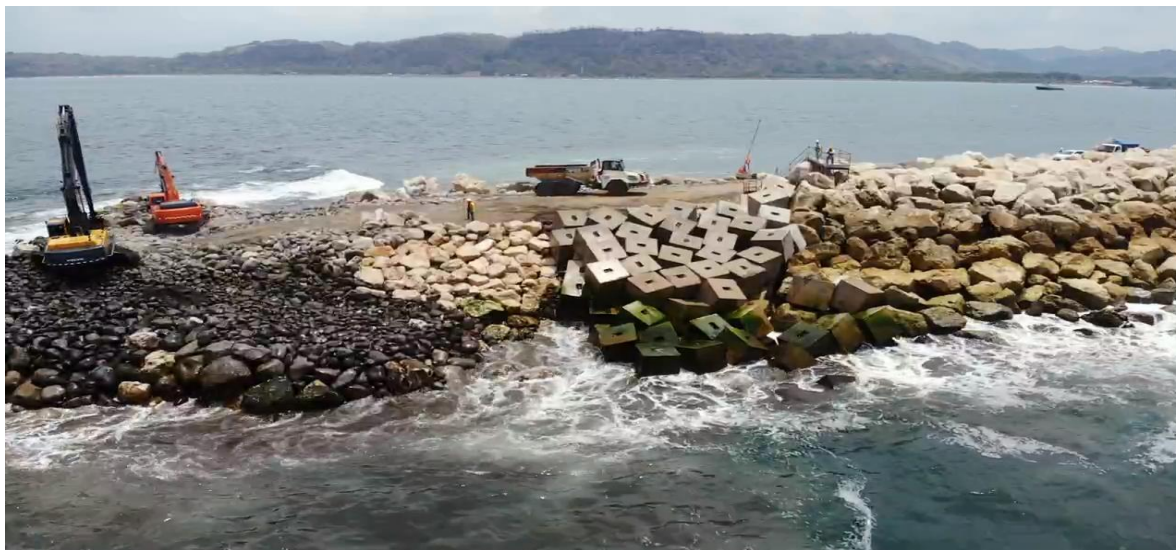
Imagen N°9. colocación de material en el rompeolas.
