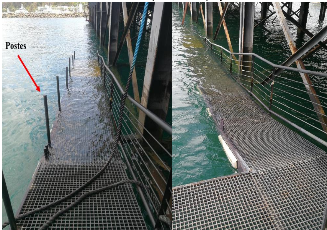
Figuras N° 17 y 18 Eliminación de postes en la rampa fija.
