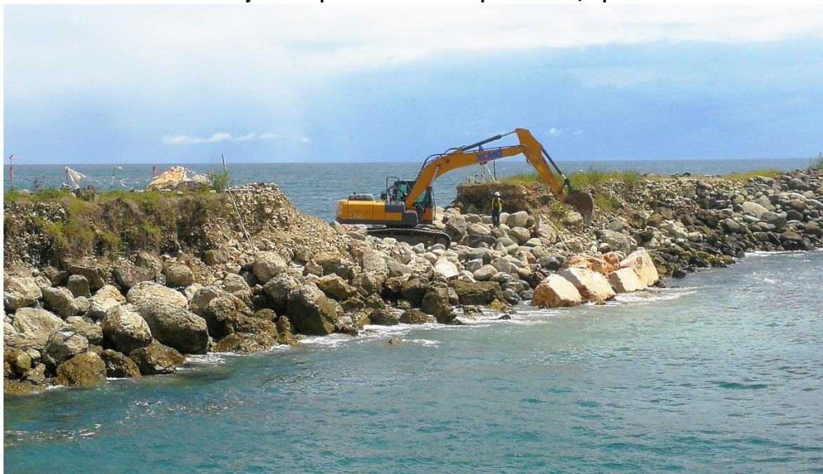
Figura N° 20 Trabajos de reparación en el rompeolas de Quepos.
