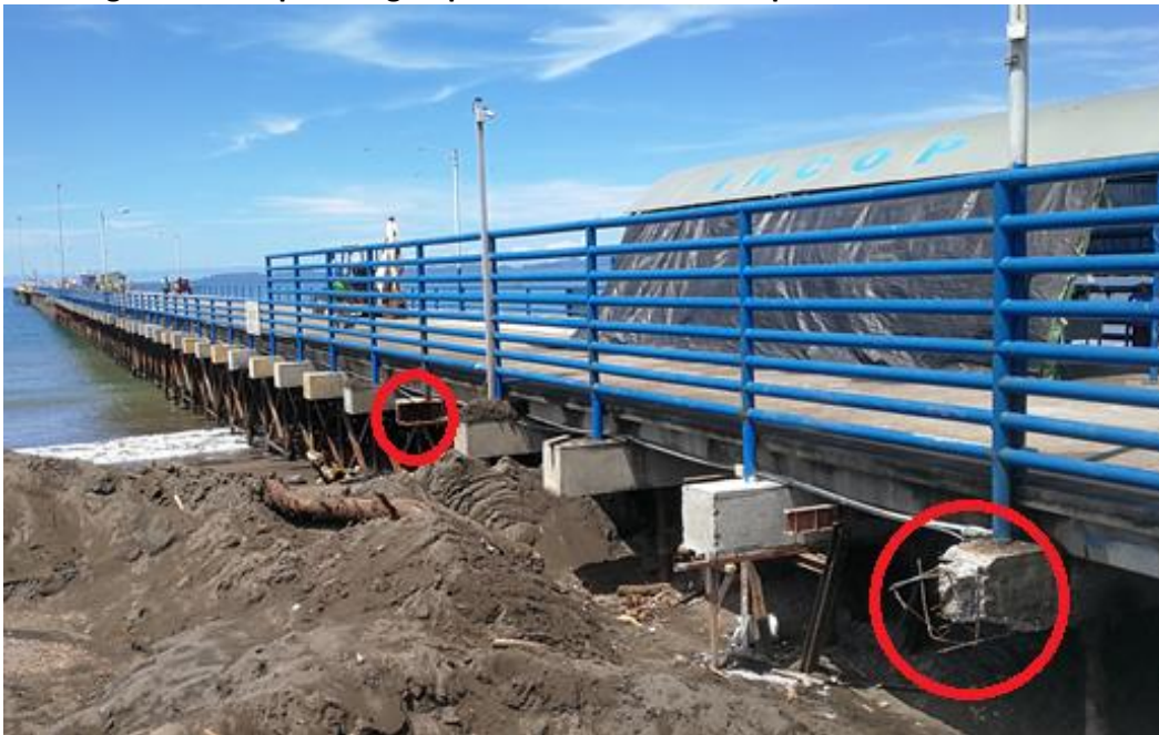
Figura N° 25 Algunas de las pocas vigas que aún se encontraban pendientes de reforzar.
