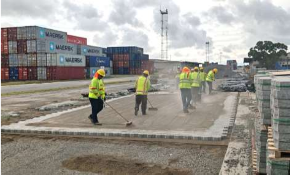
Figura N°7 Sustitución de base y colocación de adoquines en patio N°3, Puerto Caldera.
