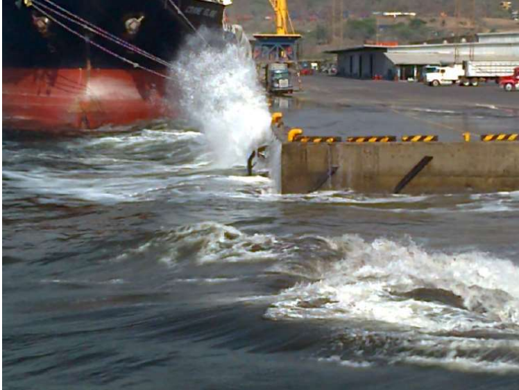
Figura 3-14 Rompimiento del oleaje frente al primer puesto de atraque por efecto de la poca profundidad debida a la sedimentación
