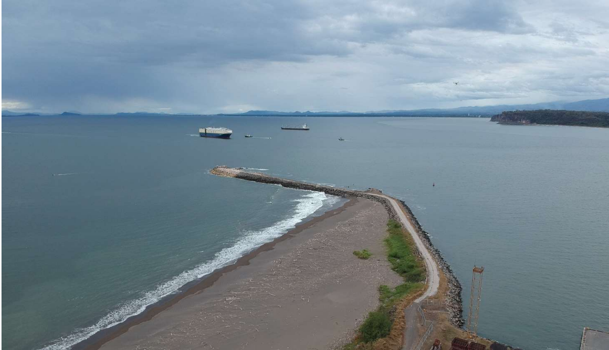
Figura 3-11 Rompeolas de Puerto Caldera
