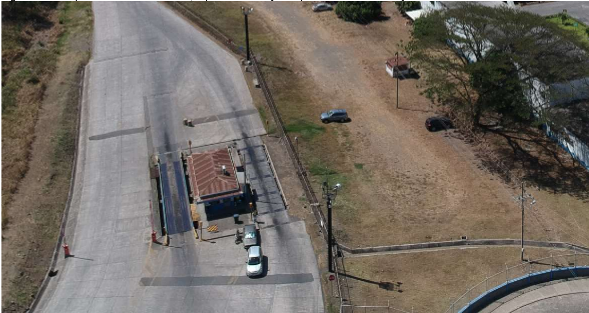
Figura 3-35 Estación de pesaje con una báscula por sentido
