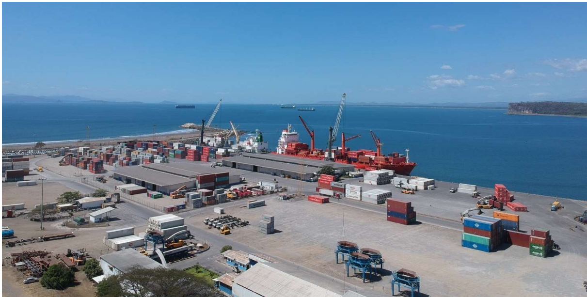
Figura 3-41 Descarga de dos buques portacontenedores en el muelle 1 y 2 con equipo de barco y grúas móviles
