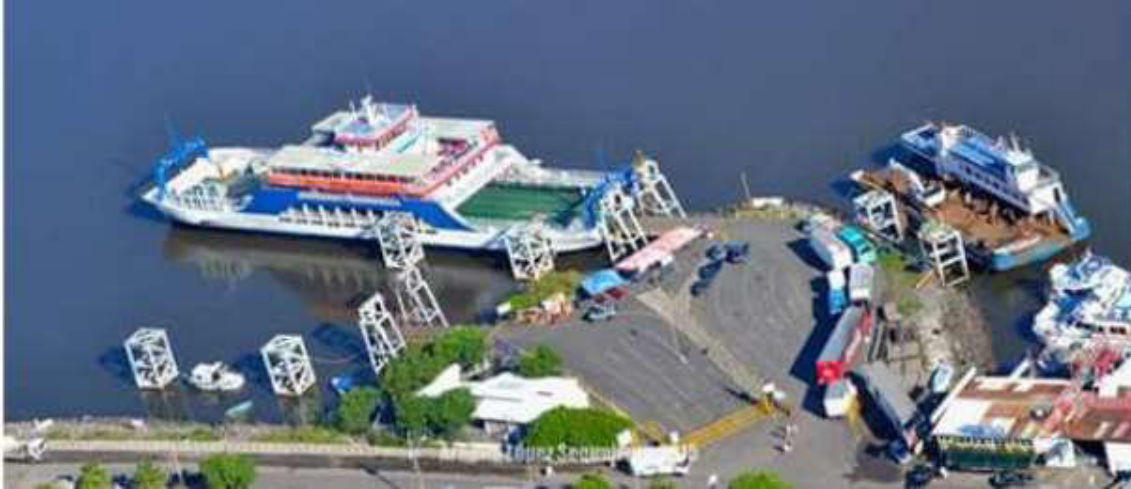
Figura 3-34 Vista aérea Terminal Barrio El Carmen
